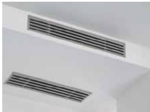
Installazione a soffitto.
